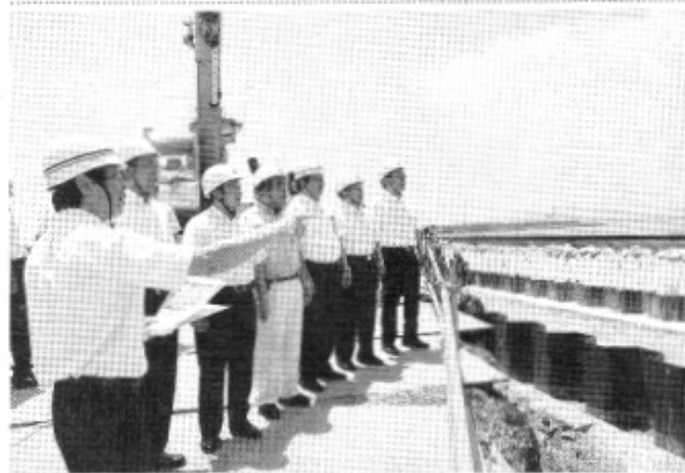
豊橋海岸で堤防の補修工事現場を視察する 党愛知県議団(右から6人)
