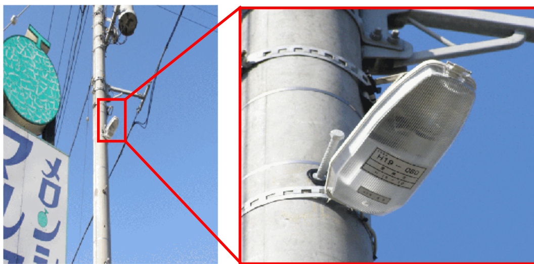
設置された照明灯
